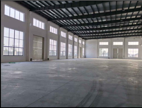
厂房内部照片
