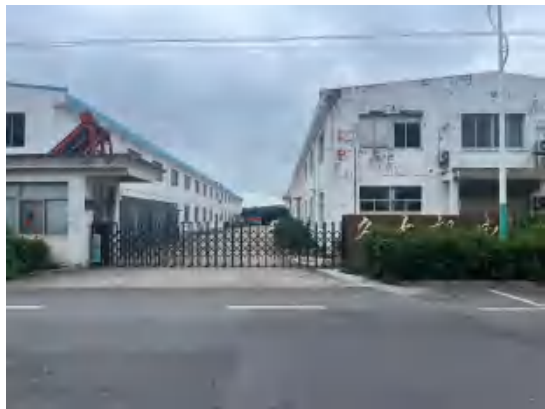
项目南侧-江苏林进达汽车零部件有限公司
