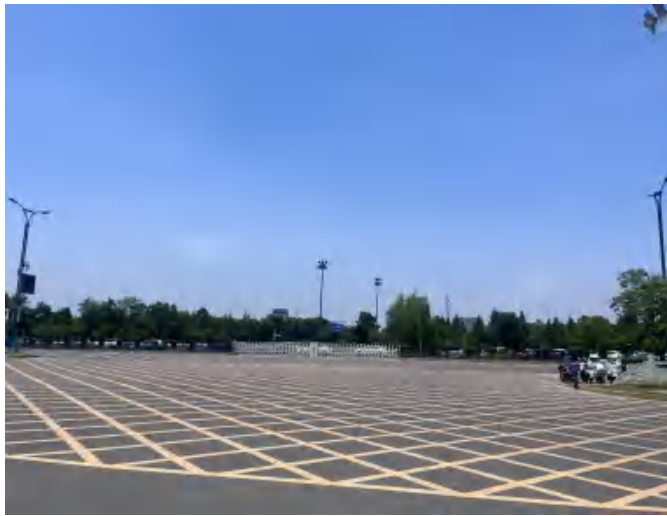
项目北侧盐渎路和空地
