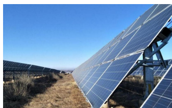
图 2-3 固定可调式支架安装方式示意图
